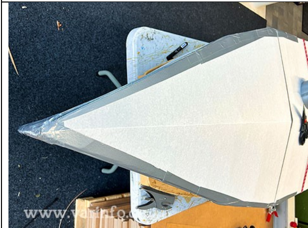
Nähte sauber und Wasserdicht abkleben
