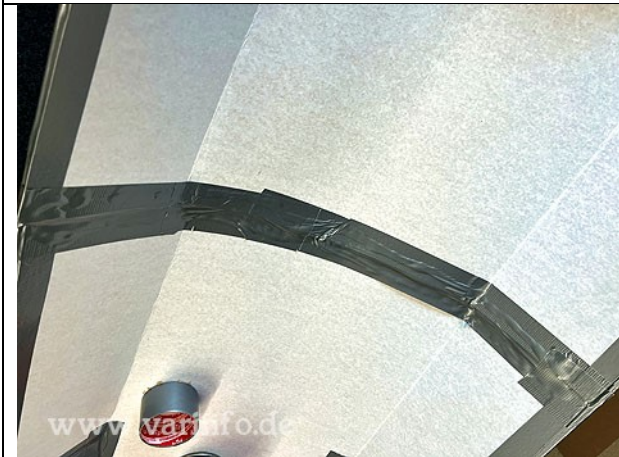
Alle Nähte wasserdicht abkleben
