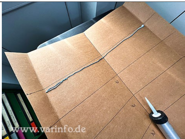
Montagekleber ca. 1 cm neben Linie dünn auftragen
