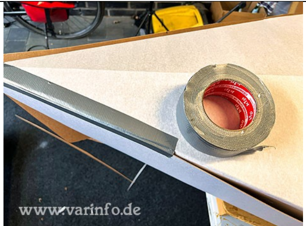
Klebeflächen mit Azeton reinigen und Nähte sehr sauber von außen nach innen verkleben
