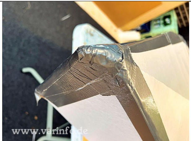
Spitzen wasserdicht abkleben
