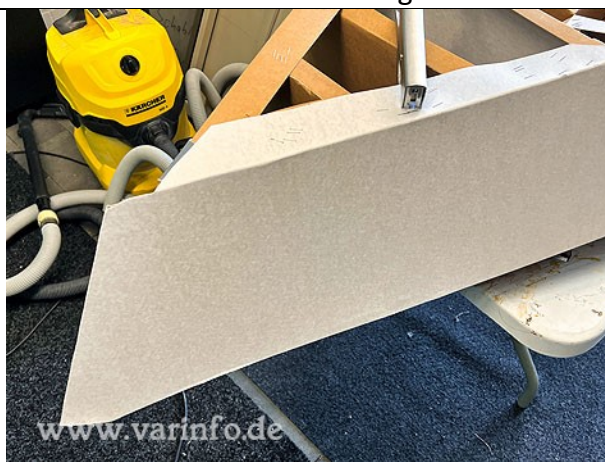
Seitenverkleidung vorne und hinten anpassen und zunächst innen montieren. Eventuelle Kunststoffbeschichtung außen.
